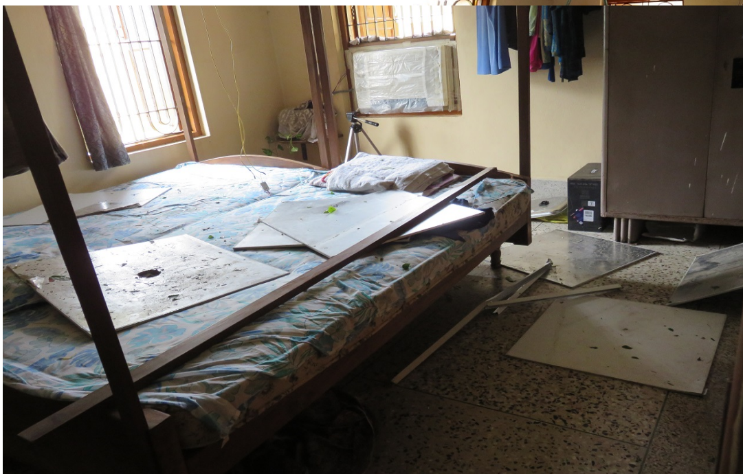
ナオミビルディングの内部と外部の被害状況 剥がれ落ちた天井が部屋に散乱している
